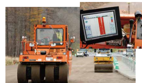
タイヤローラーによって路盤を固める転圧作業
