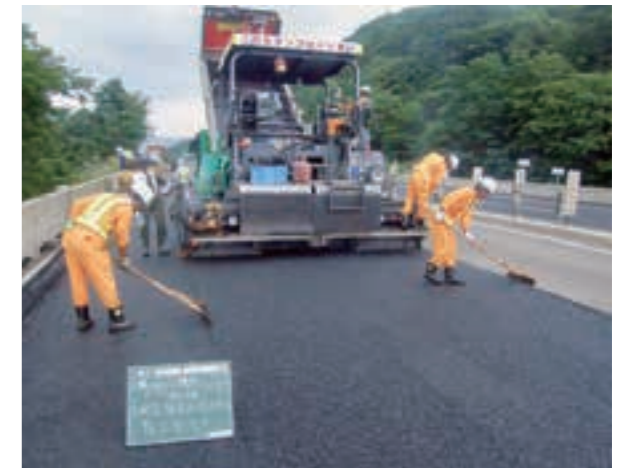
フェーゲル社製アスファルトフィニッシャー S1603-2/AB500-2TV（平成20（2008）年2月、東北自動車道盛岡管内舗装補修工事から現場投入）
