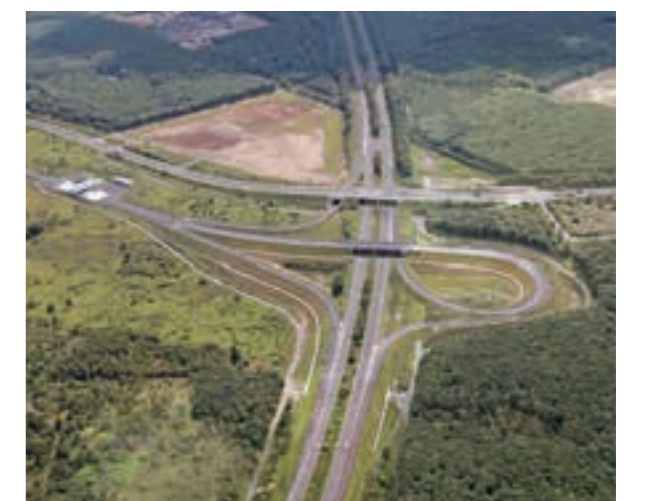
道央自動車道新千歳空港インターチェンジ舗装工事(平成25(2013)年11月竣工)
