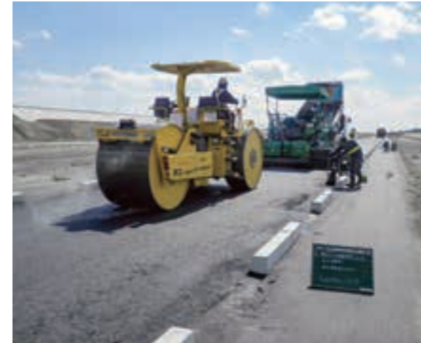
仙台湾南部海岸蒲崎工区復旧工事(平成27(2015)年3月竣工)
