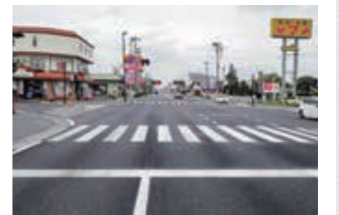
盛岡地区舗装修繕工事(平成24年度)
