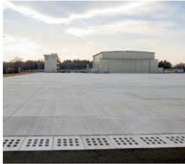
入間(28)格納庫新設舗装工事(平成30(2018)年3月竣工)
