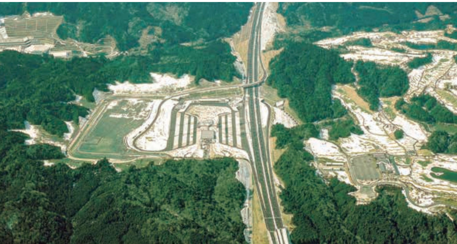
第二号神高速道路土山地区舗装工事(平成20(2008)年3月竣工)
