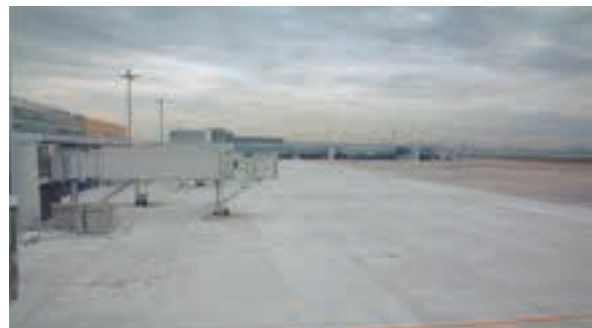
平成15年度東京国際空港東側ターミナル地区エプロン舗装工事・その8(平成16(2004)年11月竣工)
