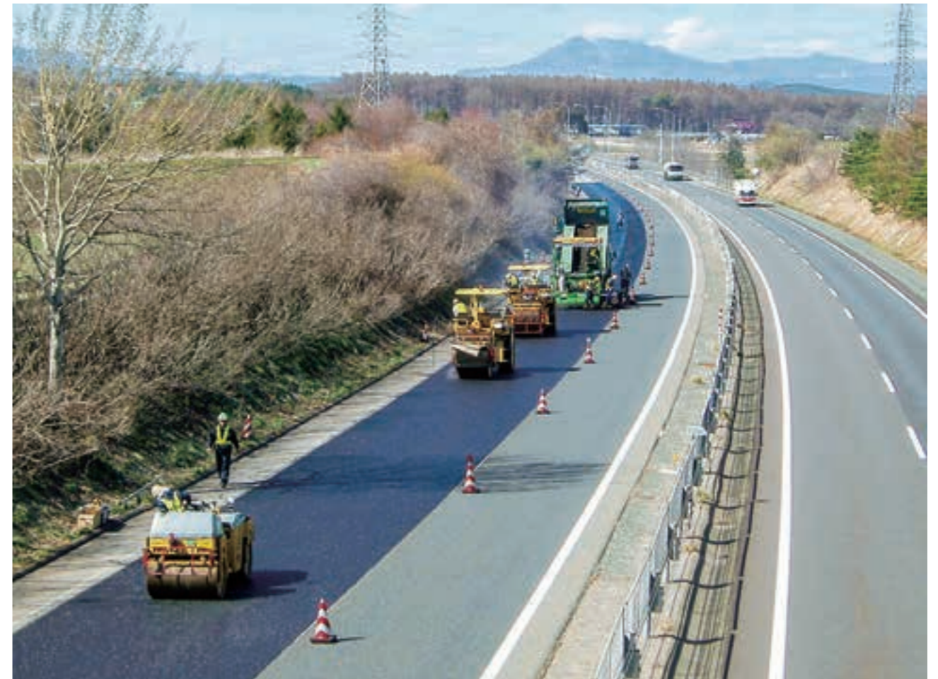
東北自動車道盛岡管内舗装補修工事(平成21<2009>年11月竣工)
