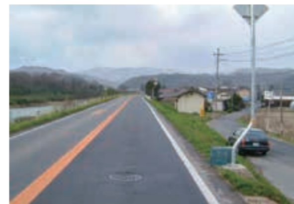
円山川日高上流地区情報管路設置工事(平成14(2002)年3月竣工)
