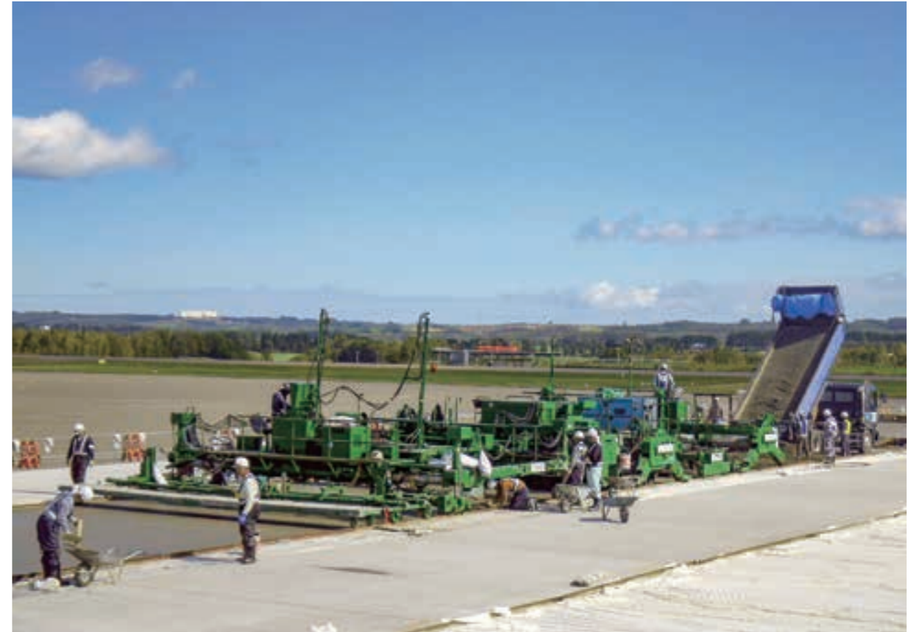
女満別空港整備エプロン及び誘導路舗装工事 (平成27 (2015) 年12月竣工・コンクリートスプレッダ KS85A、コンクリートフィニッシャ KF85A、コンクリートレベラ KL85A を使用して施工)
