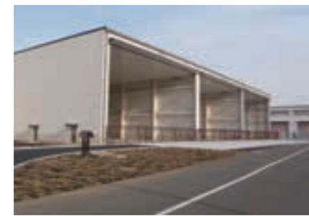
相模米軍(26)倉庫(0502)新設舗装工事 (平成28年度)
