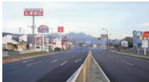
大平舗装修繕工事(平成15(2003)年11月竣工)
