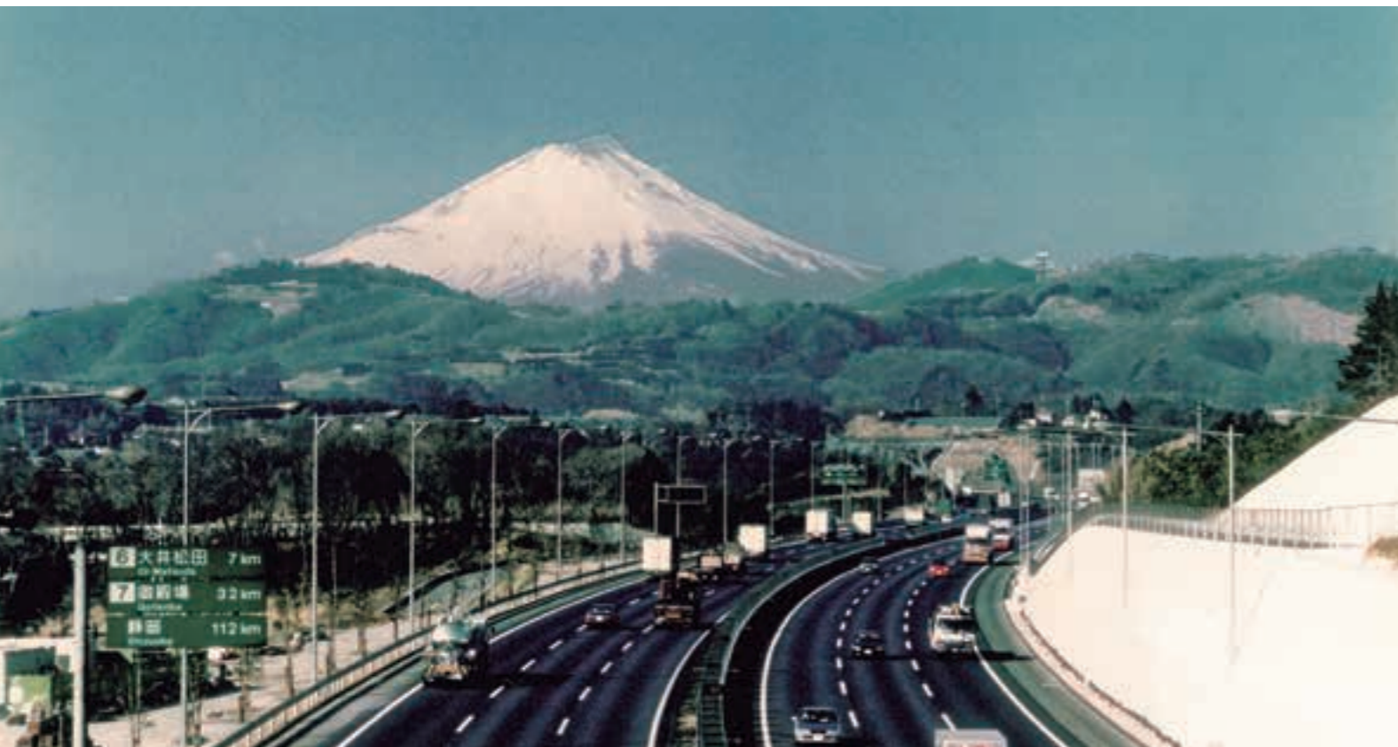
東名高速道路(改築)中井舗装工事(平成7(1995)年3月竣工)
