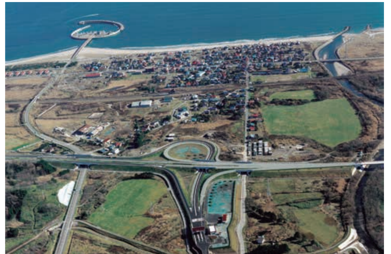
北海道縦貫自動車道国縫舗装工事(平成14(2002)年1月竣工)
