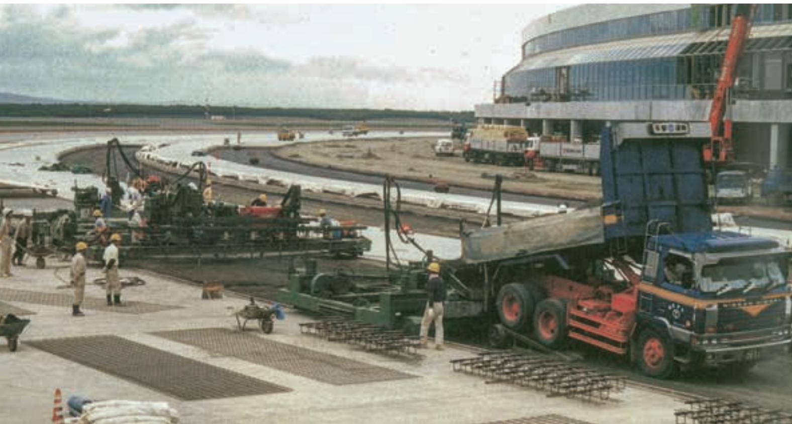
新千歳空港エプロン新設その5工事(昭和63(1988)年11月竣工)
