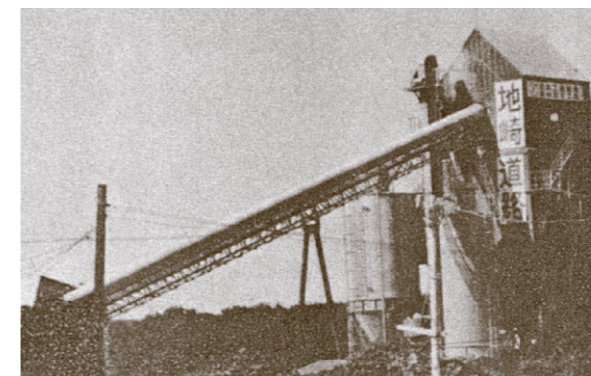
千歳工事事務所内に誕生した生コン JIS工場
