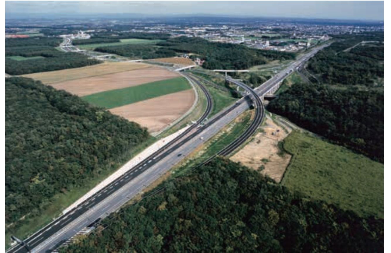
北海道横断自動車道千歳西舗装工事(平成11(1999)年11月竣工)
