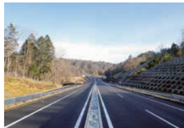
北海道横断自動車道白糠町大曲東舗装工事 (平成27(2015)年11月竣工)
