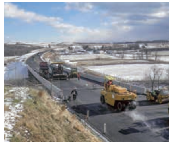
日高自動車道日高町旭町東舗装工事 (平成30(2018)年3月竣工)
