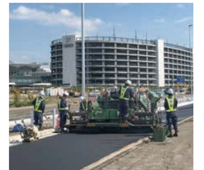
東京国際空港国際線地区構内道路舗装等工事(平成30(2018)年3月竣工)
