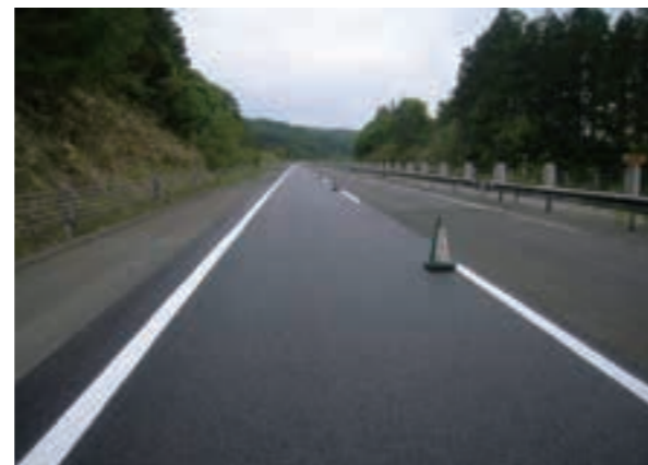
東北自動車道花巻～安代間舗装補修工事(平成26(2014)年1月竣工)
