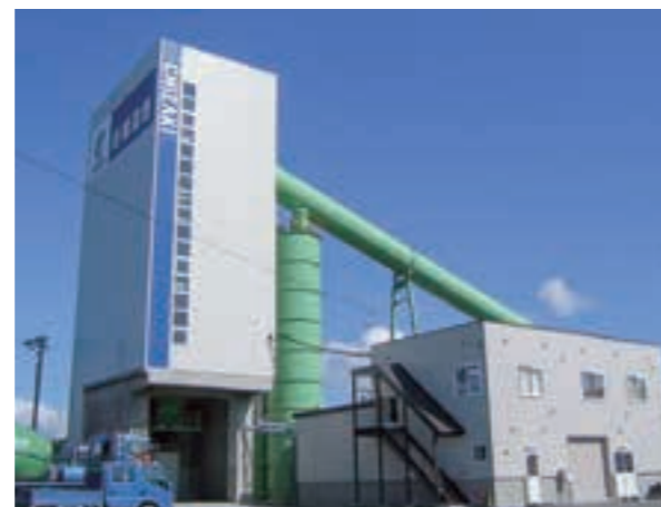
千歳生コン工場(平成18<2006>年6月)
