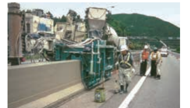
スリップフォーム工法にて施工・平成6年度名神高速道路関ヶ原地区中分防護柵改良工事(平成7(1995)年7月竣工)
