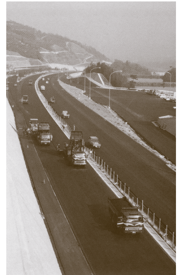
一般国道30号粒江舗装工事(昭和63(1988)年4月竣工)
