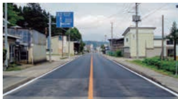
小松地区他舗装修繕工事(平成17(2005)年6月竣工)
