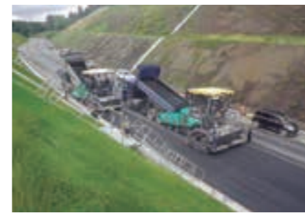
北海道横断自動車道訓子府町三豊舗装工事 (平成28年度)
