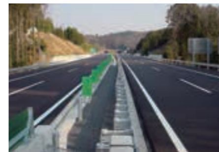
東海環状自動車道 豊田北舗装工事(平成17年度)
