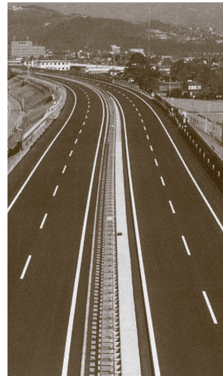
中央自動車道松本舗装工事(昭和63(1988)年5月竣工)
