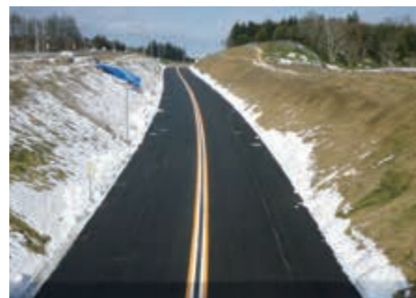
北海道横断自動車道陸別町利上北舗装工事(平成28(2016)年12月竣工)
