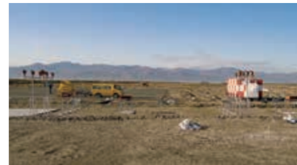
実物大の空港施設を用いた液状化実験(石狩湾新港)(平成19(2007)年12月実施)
