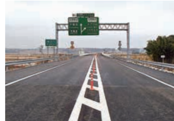
北関東自動車道水戸管内舗装災害復旧工事(平成25(2013)年3月竣工)
