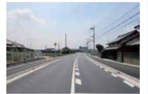
大和御所道路天理東地区改良工事 (平成29年度)
